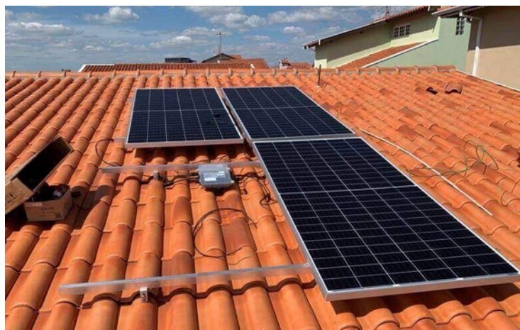
Figura 1: Microinversor instalado junto às placas fotovoltaicas.
