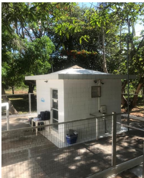
Casa de Proteção
