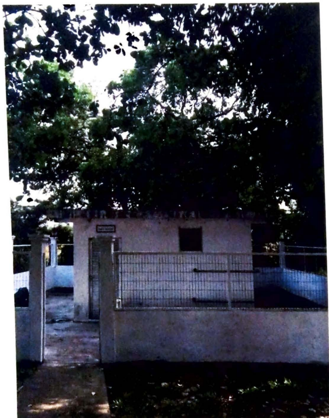
Foto 01 - Vista Externa da Casa de Proteção
