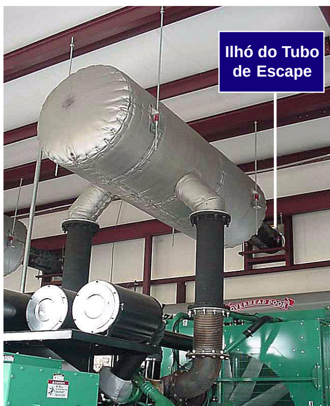
Figura 6-7: Características do Sistema de Escape do Grupo Gerador. São mostrados: Silenciador com Dupla Entrada, Conectores Flexíveis, Ilhós da Tubulação de Escape e Ganchos de Montagem.
