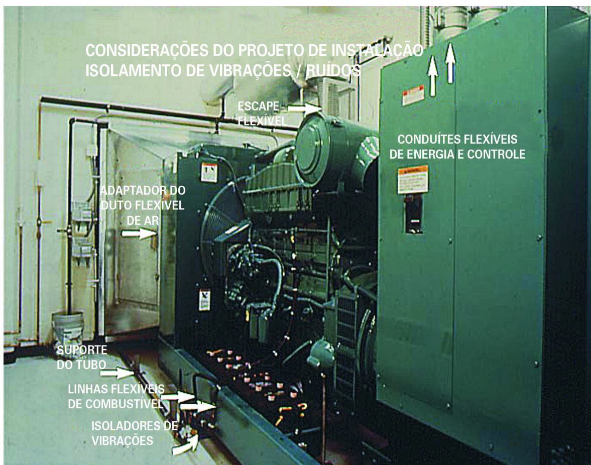
Figura 6-1. Provisões Anti-Vibração para um Grupo Gerador Típico
