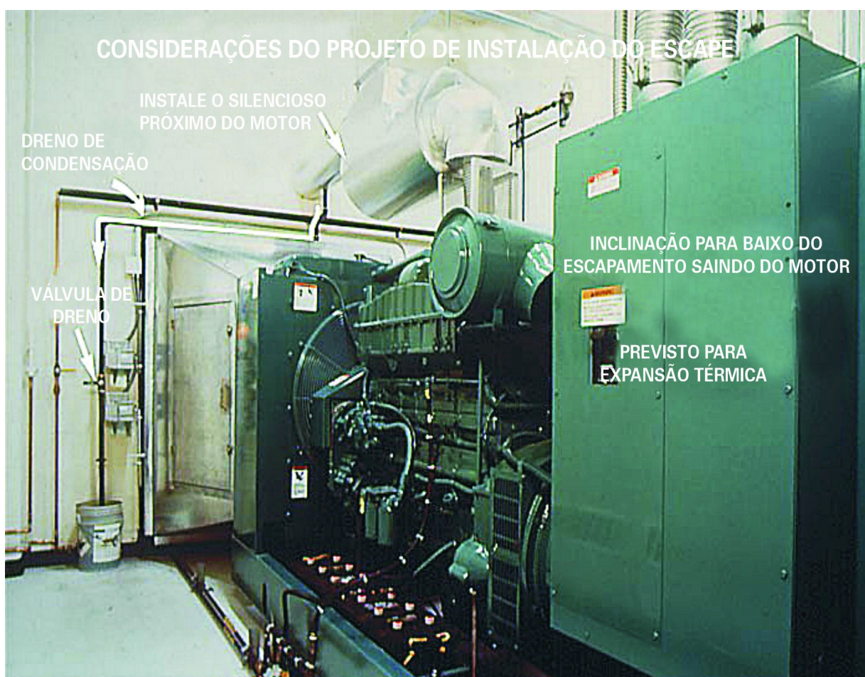
Figura 6-5: Características Típicas de um Sistema de Escape para um Gerador Instalado Dentro de um Edifício
